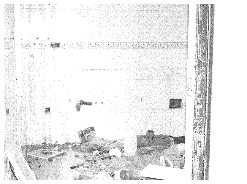
MOBILIARIO DE COCINA - ESTADO ACTUAL
